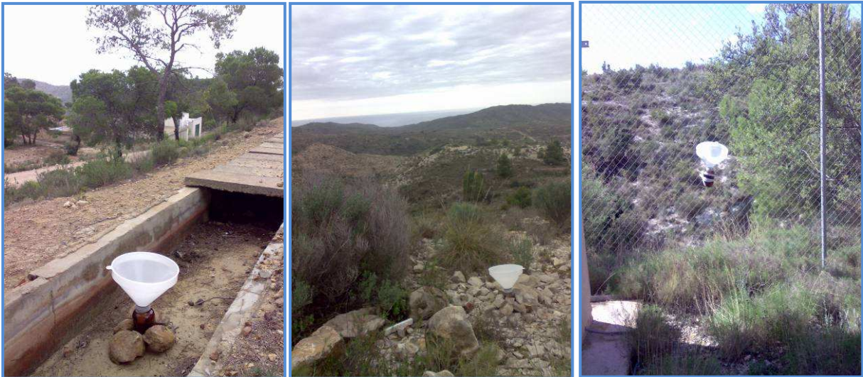
Fotografía nº 24.- De izquierda a derecha, detalle de colectores de Aigües, Busot y Finestrat. Éste último en el interior del recinto del pozo Farella (2933-8-112) del abastecimiento de Finestrat
